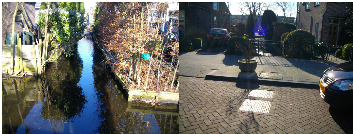
Verbindingssloot in polderdeel Zuid en putten van het hemelwaterriool
