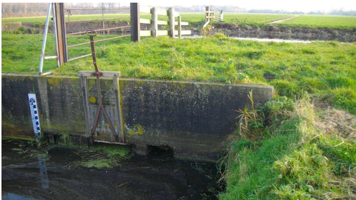
Figuur 10 Sifon 13, met daarnaast de inlaat vanuit het boezemwater.
