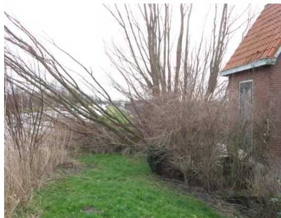
Te slopen gemaal in boezemkade van kadevak 5B.
