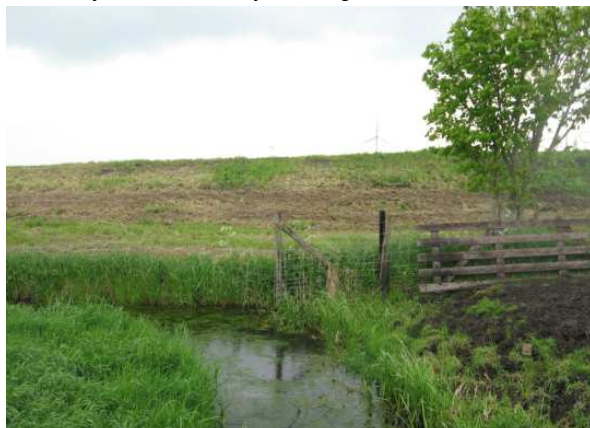
Zicht op locatie aan te leggen duiker onder de Galgweg.
