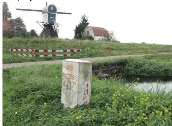
Uitstroomzijde sifon kadevak 9 met te verplaatsen fietspad.
