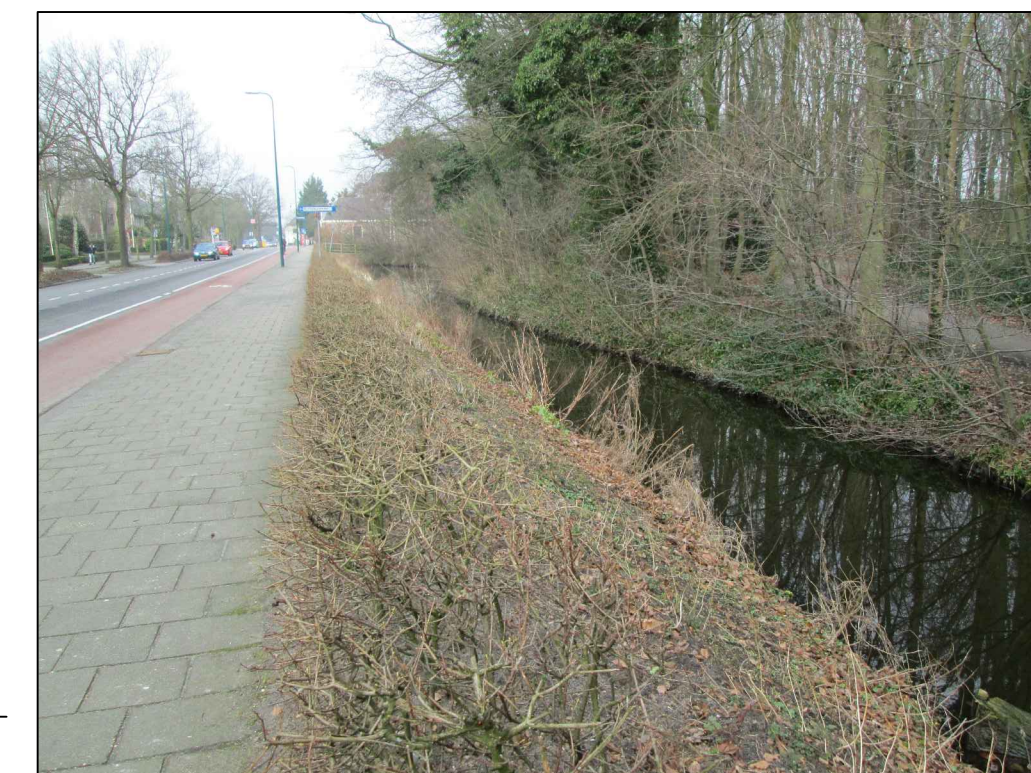
LOCATIE NIEUW GEMAAL
