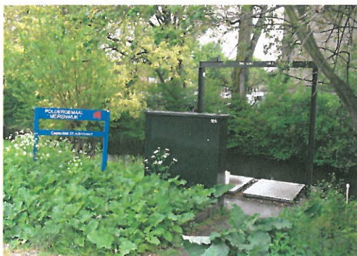
Figuur 1B Foto poldergemaal Merenwijk, huidige situatie.
