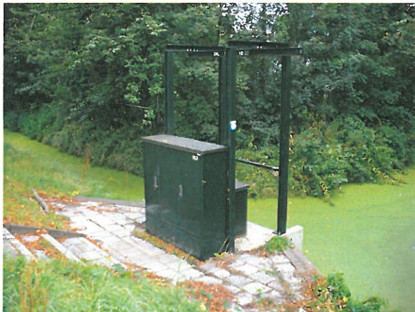
Figuur 1B Foto poldergemaal Kanaalweg, huidige situatie.
