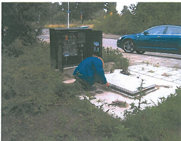
Figuur 1B Foto poldergemaal Floris Versterlaan, huidige situatie.
