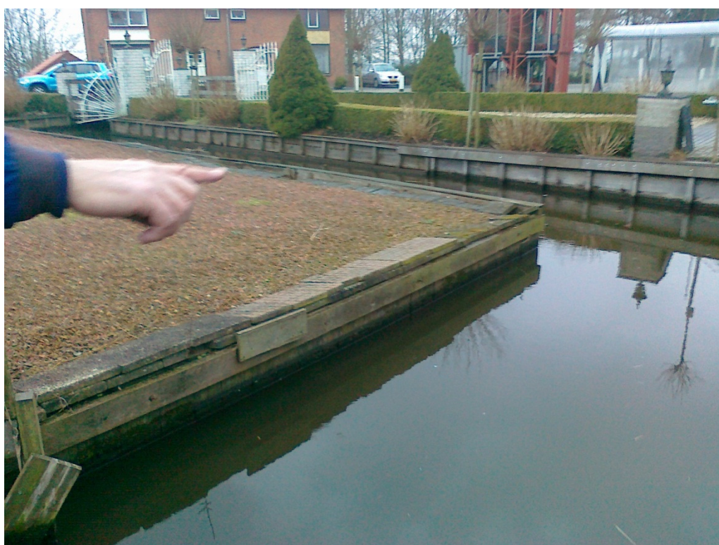
Foto 4 – beschoeiing en grindverharding tussen Woudsedijk 5 en 7
