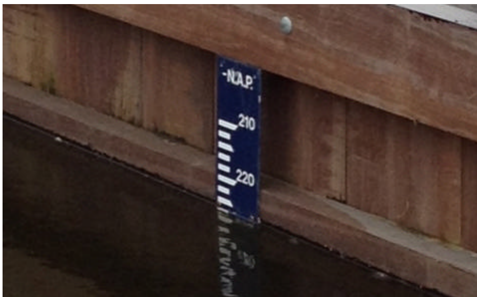
Foto 19. Op een peilschaal is het actuele oppervlaktewaterpeil af te lezen
