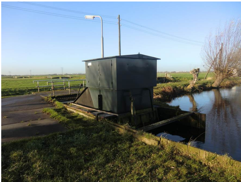
Huidige gemaal Achterbroek
