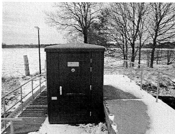
Fotonummer: 2 Omschrijving: Deellocatie 1: Stuw op meest westelijke punt
