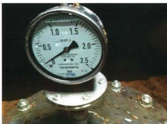
Afbeelding 3.1: DWA-pomp + RWA-pomp in bedrijf
