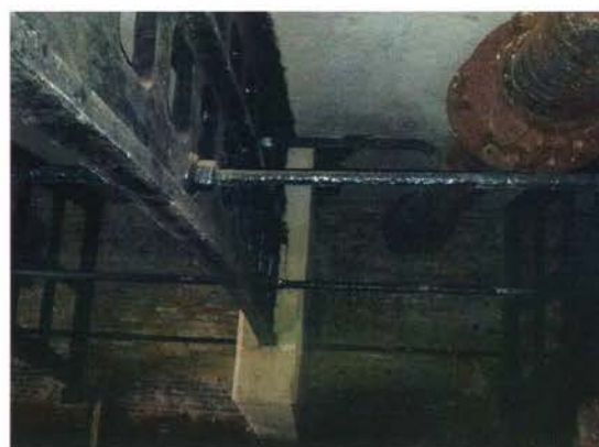
Afbeelding 1.8: Aanzicht hersteld spant
