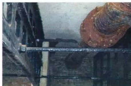
Afbeelding 5.3: Lagedruk gasleiding
