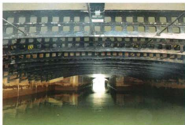
Afbeelding 1.7: Aanzicht gietijzeren spanten
