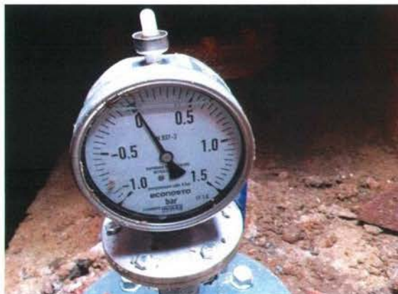
Afbeelding 3.7: DWA-pomp + RWA-pomp in bedrijf
