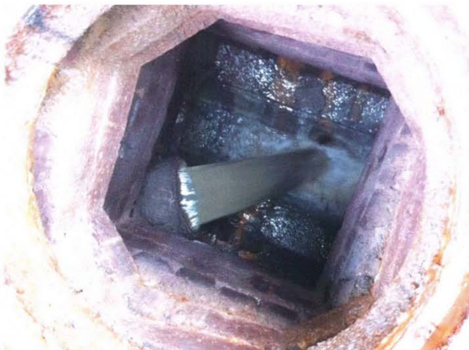
Afbeelding 2.5: Uitstroming leiding in put Statenplein
