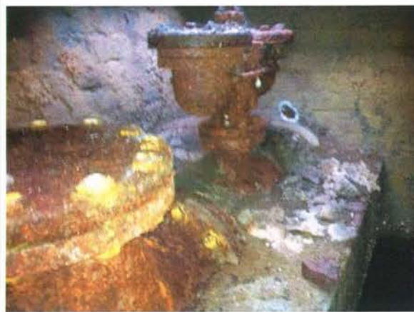
Afbeelding 2.2: T-stuk met beluchter Voorstraat
