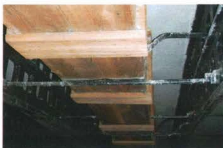
Afbeelding 5.4: Waterleiding in kist
