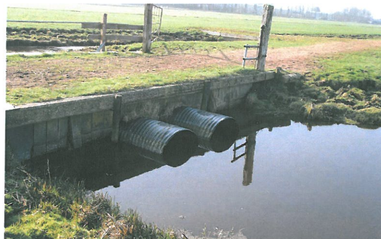
foto bestaande duikers, dam
