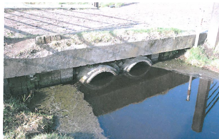
foto bestaande duiker noordoostzijde
