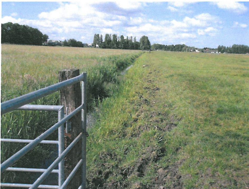
ID 4: Overzicht van bestaande scheislout, gezien richting Papenlaan-West Maatregel: Verbreden van de scheislout en vrijkomende grond verwerken op naast gelegen perceel ter hoogte van diverse slenken. Sectie B 35, B 31 en B 29; verbreding 1,00 x 615 meter lengte = 615 m 2
