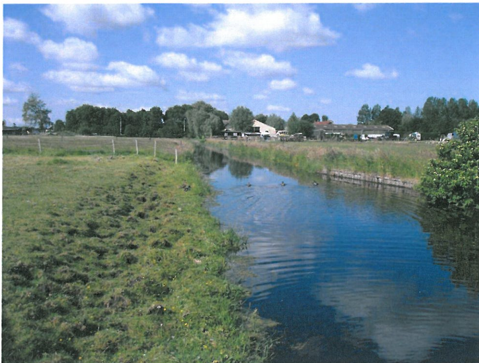
ID 1: Overzicht van bestaande hoofdwatgang vanaf de Papenlaan-West. Maatregel: Verbreden van de hoofdwatgang en vrijkomende grond verwerken op naast gelegen perceel ter hoogte van bouwlocatie en daarachter. (zie ook foto 2) Sectie B 9697; verbreding 1,50 x 400 meter lengte = 600 m 2
