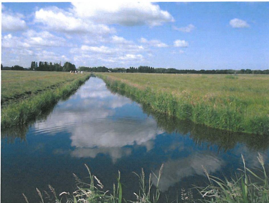
ID 6: Overzicht van bestaande hoofdwatgang richting Papenlaan-West. Maatregel: Verbreden van de hoofdwatgang tot een perceel breedte van 24,0 meter vanaf de insteek. Vrijkomende grond verwerken op naast gelegen perceel. (zie ook foto 9) Sectie B 37; verbreding ca. 2,00 x 274 meter lengte = ca. 595 m 2
