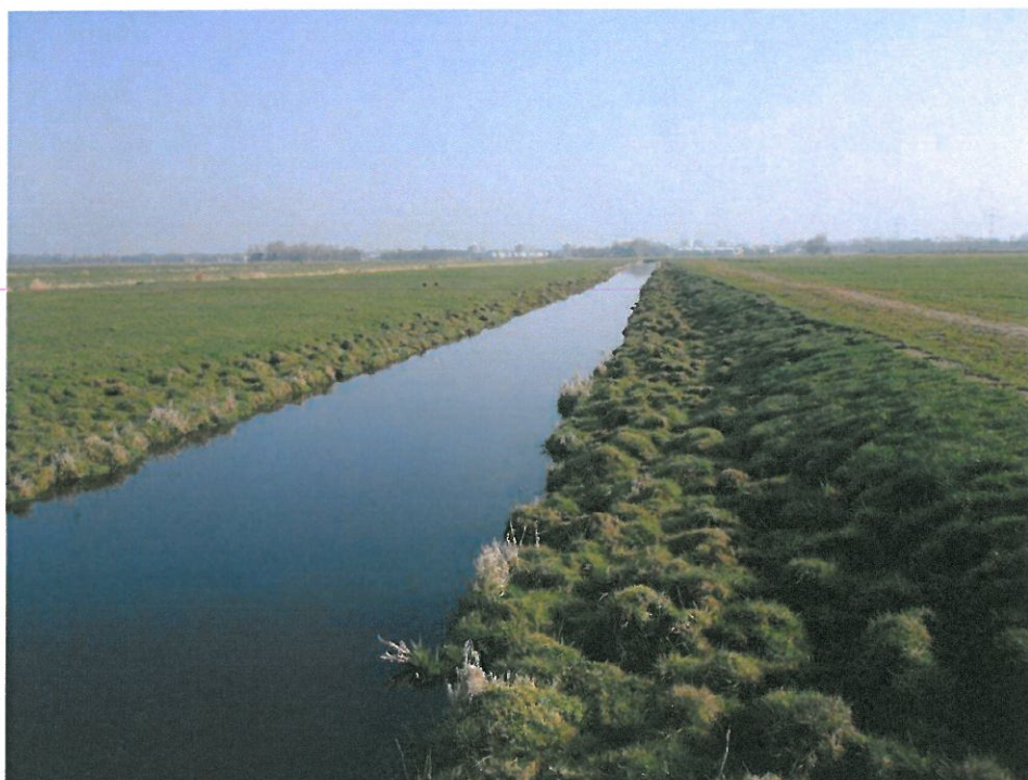
ID 7: Overzicht van bestaande hoofdwatgang met uitgetrapte oeverkant langs landbouwpad. Op de voorgrond versmalling in t.g.v. hooggelegen zandrug. Maatregel: Optrekken van uitgetrapte oeverkanten en grond verwerken op naast gelegen perceel met de benodigde cultuurtechnische bewerkingen en inzaaien met een paardenmengsel. Geen natuurvriendelijke oevers. Sectie B 35; verbreding ca. 0,50 x 500 meter lengte = ca. 250 m 2
