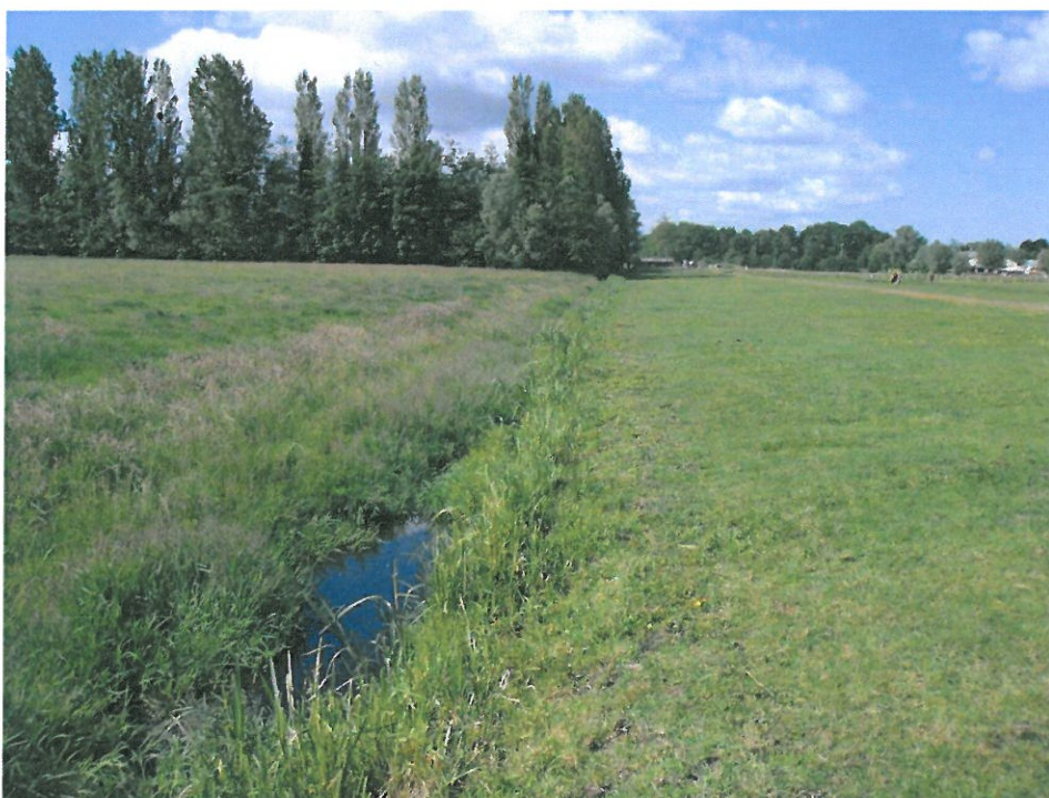
ID 3: Overzicht van bestaande scheisloot, gezien richting Papenlaan-West Maatregel: Verbreden van de scheisloot en vrijkomende grond verwerken op naast gelegen perceel. Sectie B 9697; verbreding 1,00 x 150 meter lengte = 150 m2
