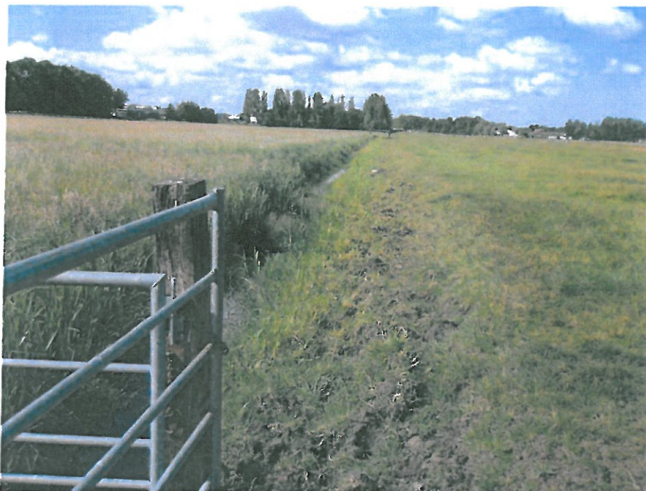
ID 4: Overzicht van bestaande scheislout, gezien richting Papenlaan-West Maatregel: Verbreden van de scheislout en vrijkomende grond verwerken op naast gelegen perceel ter hoogte van diverse slenken. Sectie B 35, B 31 en B 29; verbreding 1,00 x 615 meter lengte = 615 m 2
