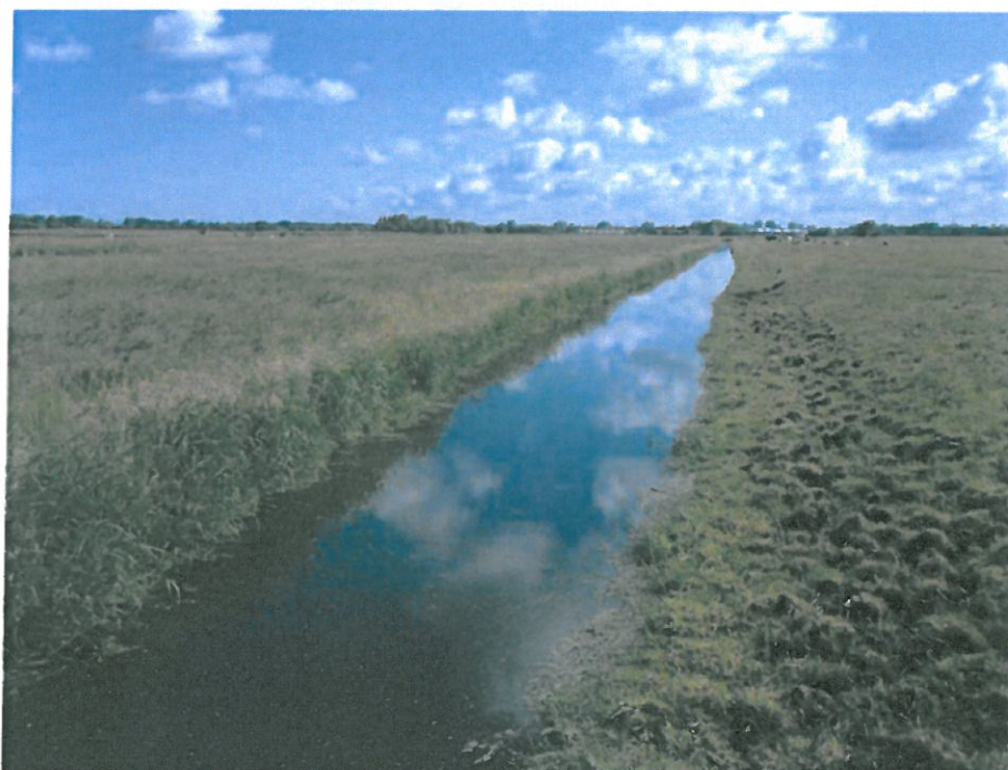
ID 5: Overzicht van bestaande hoofdwatgang vanaf de bestaande te vervangen landbouwdam. Maatregel: Verbreden van de hoofdwatgang tot een perceel breedte van 24,0 meter vanaf de insteek. Vrijkomende grond verwerken op naast gelegen perceel. (zie ook foto 9) Sectie B 36; verbreding ca. 3,00 x 254 meter lengte = ca. 790 m 2 ;
