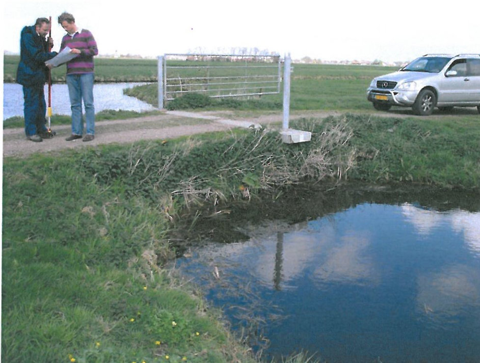
Foto 3. Aanzicht van duiker 3, in noordoostelijke richting. Maatregel: Vervangen huidige duiker door een duiker met een grotere diameter: rond 1500mm
