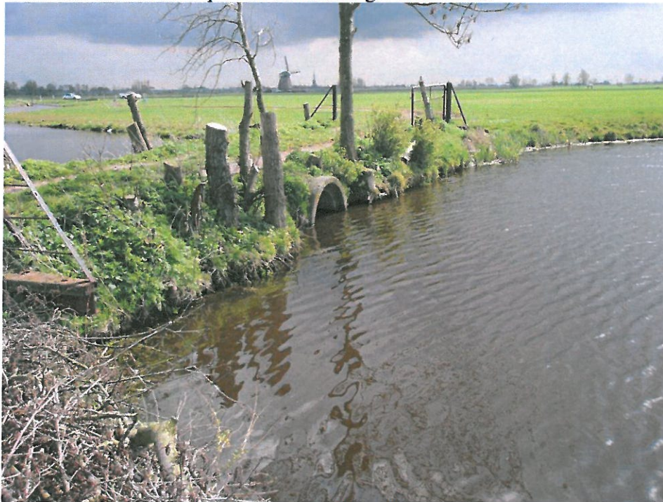
Foto 1. Aanzicht van Duiker 1, in zuidoostelijke richting.
