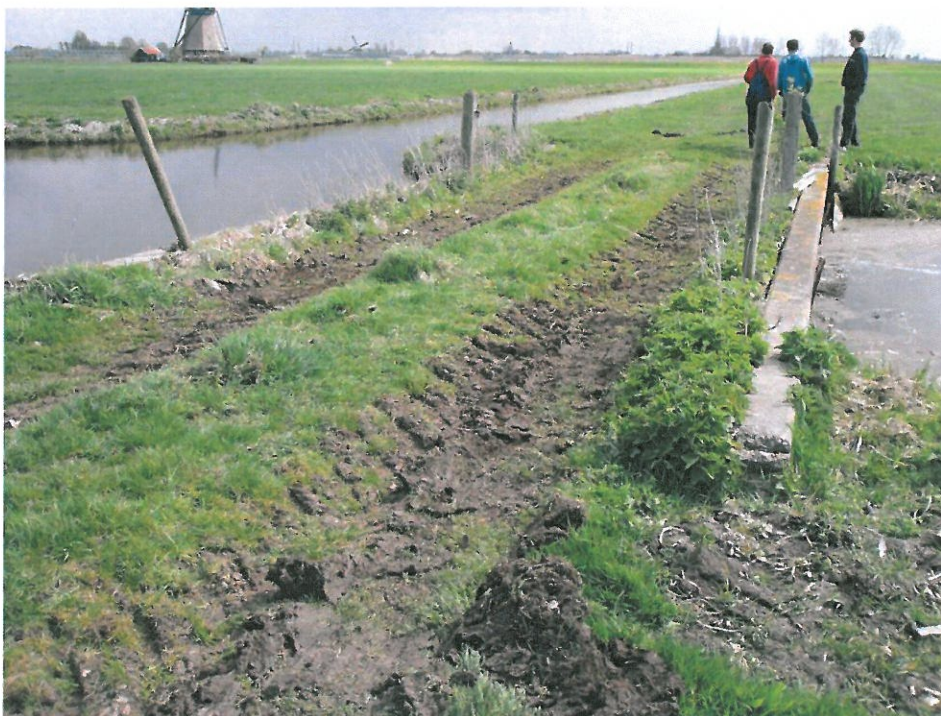
Foto 5. Aanzicht van gronddam 2, in zuidelijke richting. Maatregel: Leveren stalen duiker, lang 6m, diam. 800mm. Aanleg door pachter/eigenaar aanliggende gronden.
