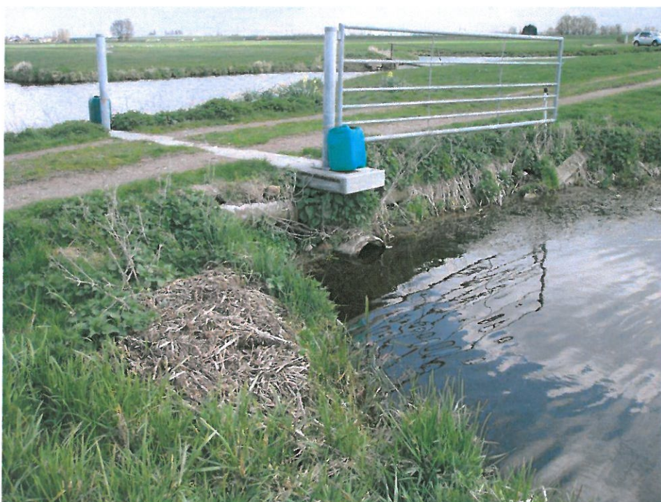
Foto 2. Aanzicht van duiker 2, in zuidoostelijke richting.
