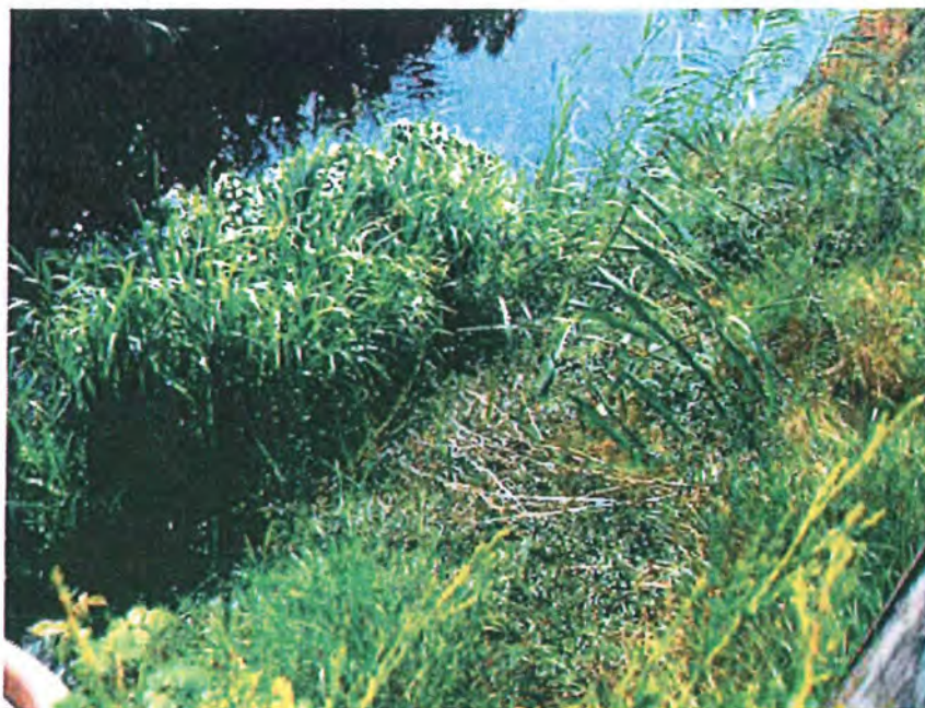
Beplantingsgroei in water naast talud aan perceel kant
