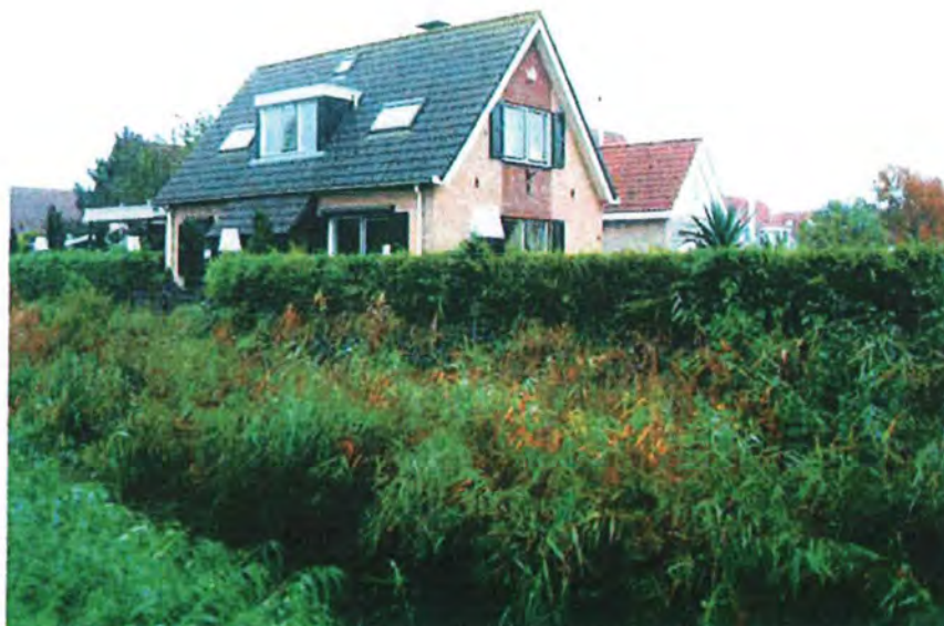
Steenkreek 20 perceel, vanaf overzijde: dichtgroei van waterdoorgang tgv rietgroei
