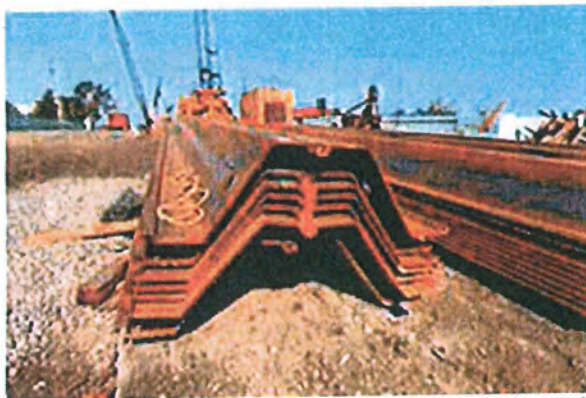
Dwarsdoorsnede van duurzame stalen damwand profielen
