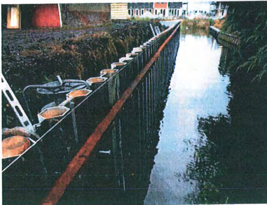
Damwand constructie aan watergang (voorbeeld situatie)
