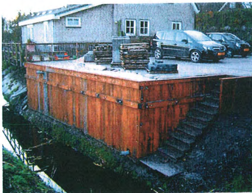
Voorbeeldfoto van eindresultaat van damwand op talud aan watergang (hout)
