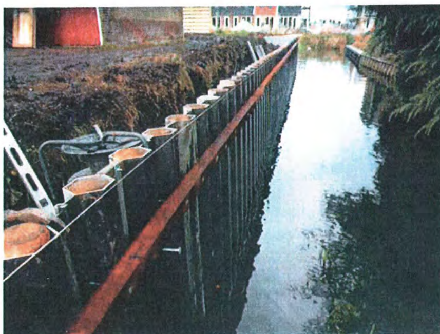
Damwand constructie aan watergang (voorbeeld situatie)
