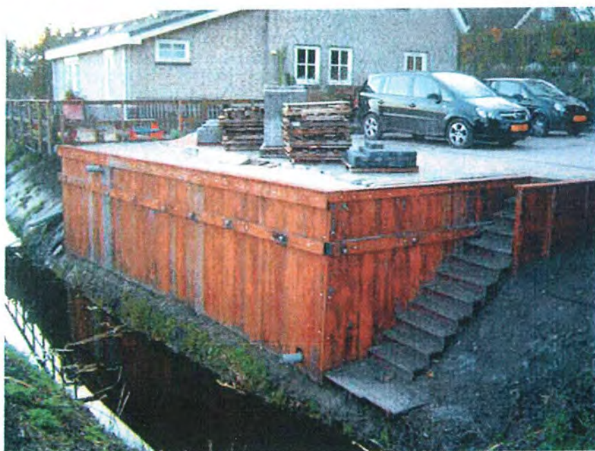
Voorbeeldfoto van eindresultaat van damwand op talud aan watergang (hout)
