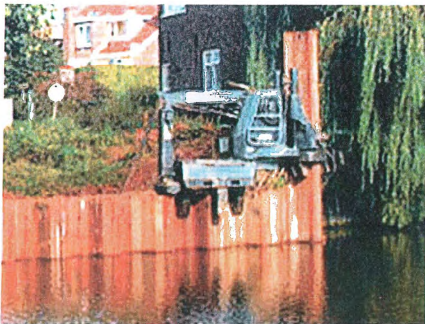
Professionele Aannemer bezig met plaatsing van damwand profielen (staal)
