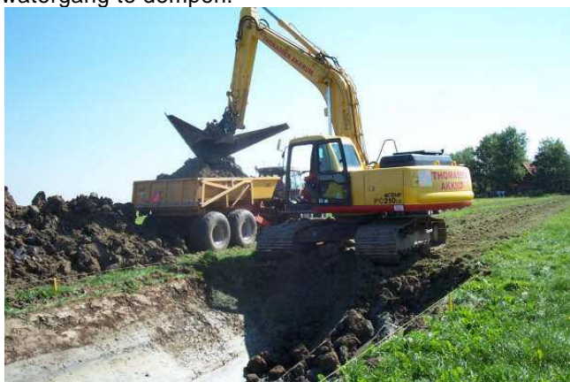
Foto 2: voorbeeld van het graven van een sloot
