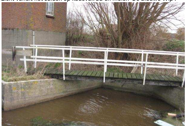
Instroomconstructie sifon kadevak 5B met daarnaast gemaal.
