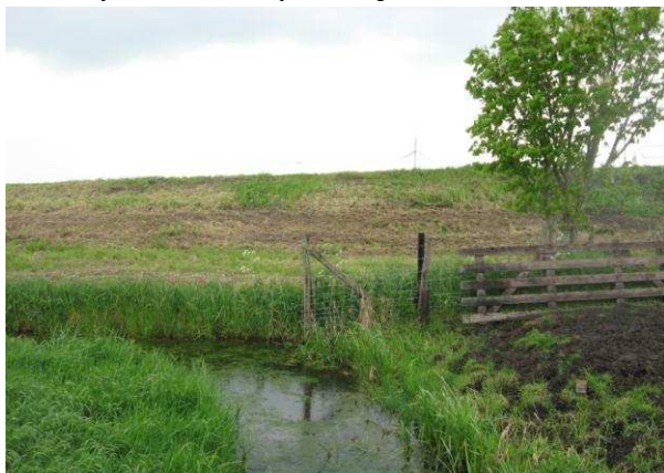
Zicht op locatie aan te leggen duiker onder de Galgweg.
