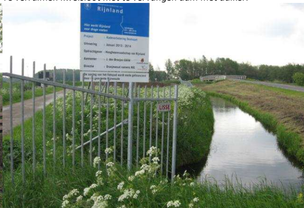
Afvoerwatergang noordzijde Galgweg en projectbord kadeverbetering 2013-2014.
