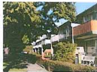
Aan de achterzijde bevinden zich balkons en tuintjes
