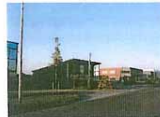
Een houten gebouw met lessenaarsdak op het bedrijventerrein
