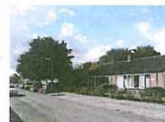
Ouderenwoningen van één bouwlaag met kap met een gezamenlijke voortuin, Viskilstraat in Mookhoek
