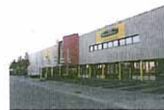
De entree wordt benadrukt door een ander kleurgebruik
