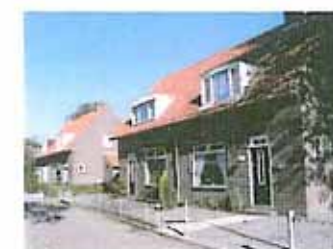
Karakteristieke twee-onder-één-kap woningen van één bouwlaag met kap, Buitenroede
