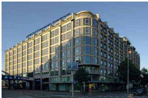
Één naamsaanduiding op een bedrijfsverzamelgebouw. (Groothandelsgebouw Rotterdam, fotomontage)
