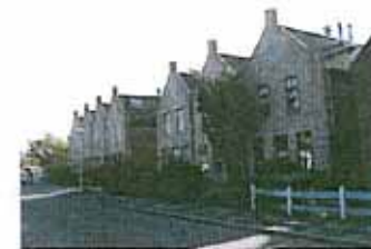
Karakteristiek bebouwingsbeeld langs de Strijense Haven
