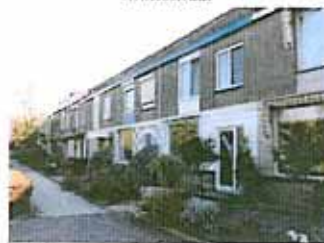
Door toepassing van tegeltjes ontstaat een wisselende gevelafwerking, Ooternaarstraat
