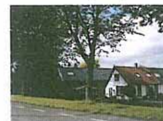
Onder aan de dijk staat een cluster woningen in een gedraaide rooilijn
