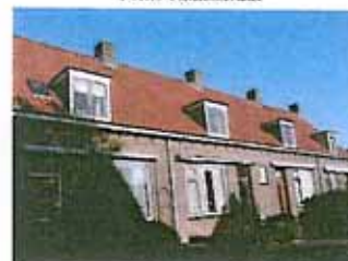
Bij deze woningen zijn regelmatig dakkapellen gebouwd, Beatrixstraat
