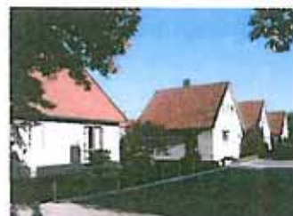
Houten woningen van één bouwlaag met kap in Strijensas, Groenewegstraat
