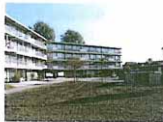
De flat van vier bouwlagen is een grootschalig bebouwingselement, Gruttostraat
