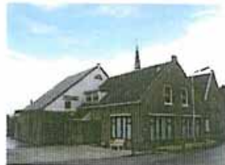
De schuur achter deze woning is zichtbaar vanaf de dijk
