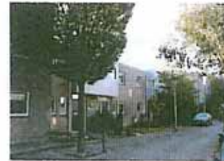
In de gevel is plaatmateriaal verwerkt, waardoor ongelijkheden ontstaan, Boomgaard
