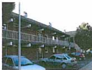
De galerijontsluiting zorgt voor een horizontale gevelsleding, De Meeren
