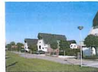
Een bijzondere afwerking van het zadeldak aan de rand van de wijk
