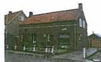
Eén van de weinige woningen met een voortuin aan de Keizersdijk
