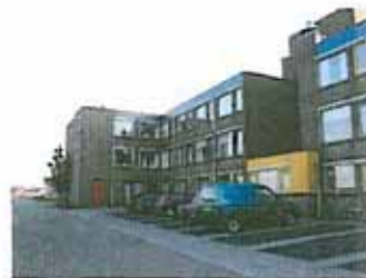
Aan de achterzijde van het complex is een donkerdere baksteen toegepast
