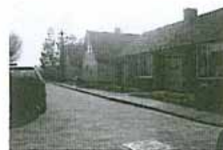
Loodrecht op de binnenhaven staan Zweedse noodwoningen
