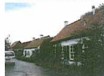
Woningen van één bouwlaag met kap staan in de rooilijn aan het plein
