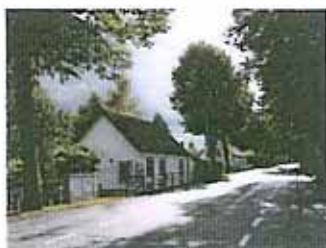
Een dijkwoning met gepleisterde gevels in Mookhoek.
