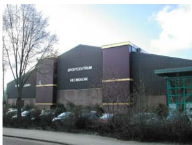
Gesloten gevels aan de openbare ruimte.
