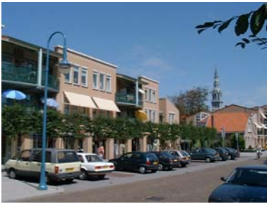
Gemengde woon-winkelpanden in het centrumdeel.
