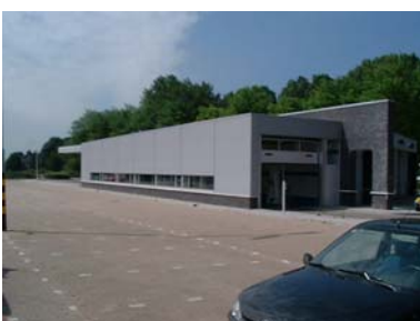
Benzinstation in de stationsomgeving staat los in de ruimte.
