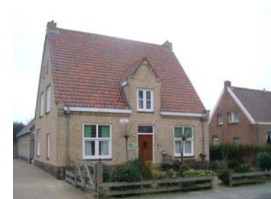
Oorspronkelijke gevel gerestaureerd. Veel details zijn behouden.
