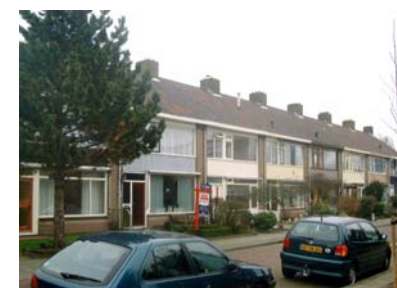
Glazen gevels op een gemetselde plint.
