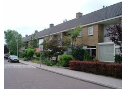
Open gevelvlak door inpandige balkons en grote raampartijen.
