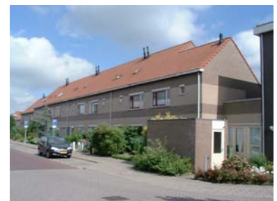
Twee kleuren steen per bouwblok.
