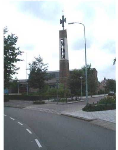
Duidelijk oriëntatiepunt op noordwest hoek van de Binnenring.
