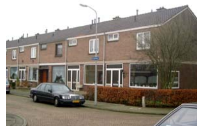
Grote ramen in de begane grondgevel.
