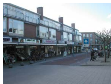
Grootschalige bebouwing met veel herhaling van gevelelementen.
