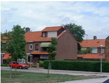
Aantasting van de hoofdvorm door combinatie van dakopbouw met erker.
