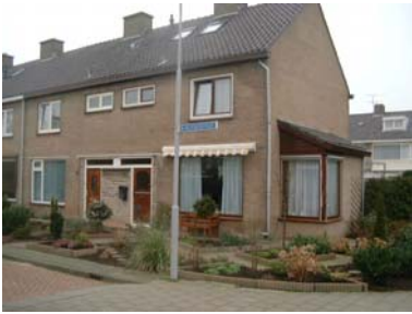
Entree wordt geaccentueerd door afwijkend metselwerk.
