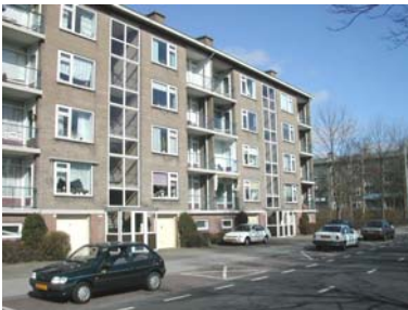
Portiekflats met een sterke verticale gevelgeleding.
