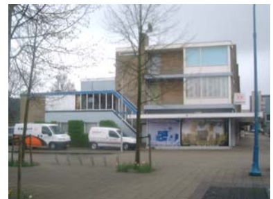
Het dichtplakken van vensters is niet wenselijk, transparantie en open wanden hebben de voorkeur.
