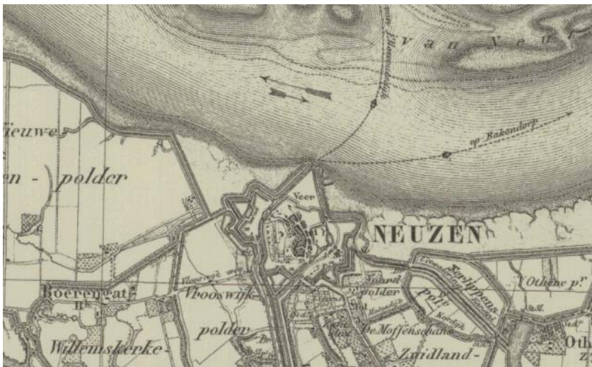
afbeelding 7: ligging oude vesting Terneuzen aan kanaal Gent-Terneuzen (1863)
