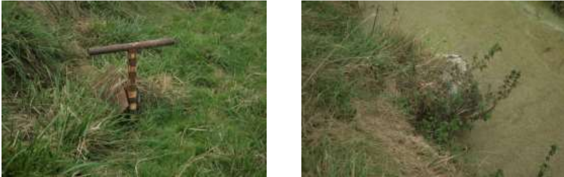
Figuur 7 Inlaatwerk aan de zuidzijde van de Leenheerenpolder welke in verbinding staat met de Leenheerengorzenpolder
