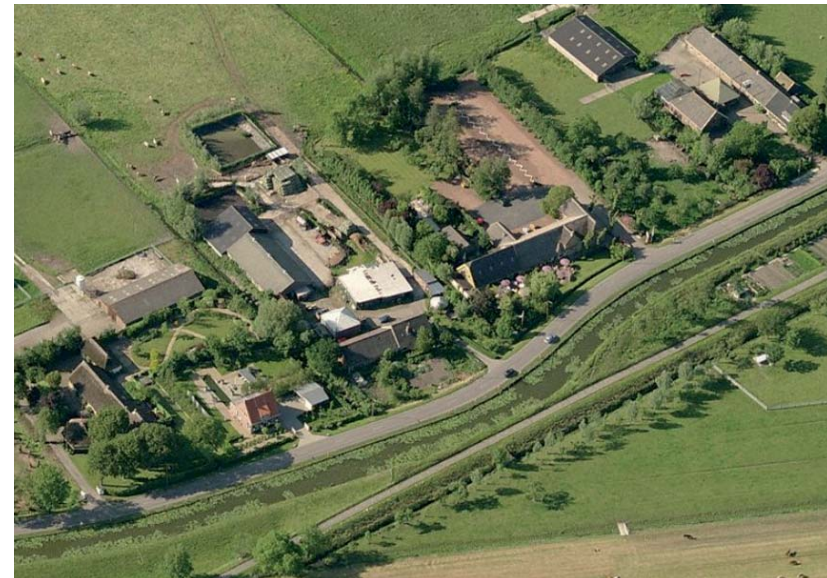
geclusterde lintbebouwing Gaagweg
