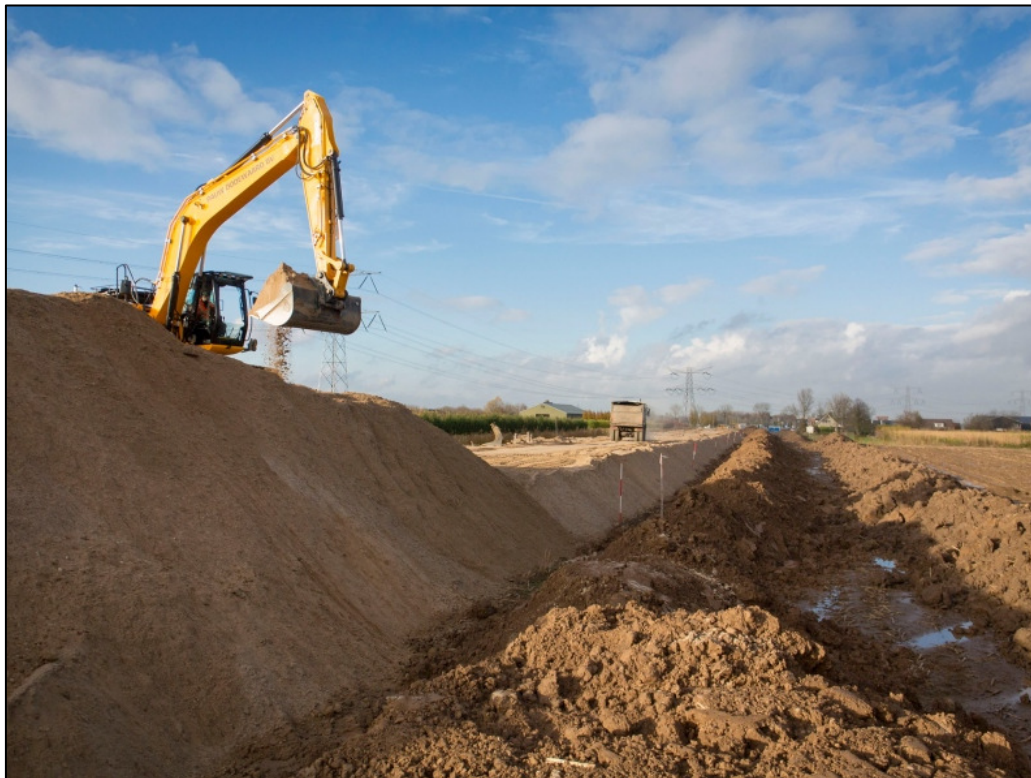
Aanleg verbindingsweg Dodewaard
