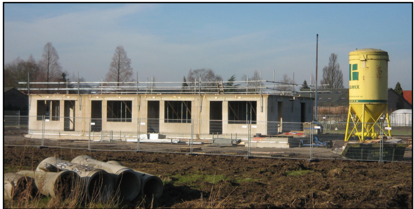
Aanbouw woningen Herenland Opheusden
