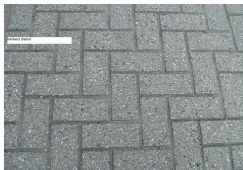
Nr 3 en 4: Klinkers Klinkers beton
