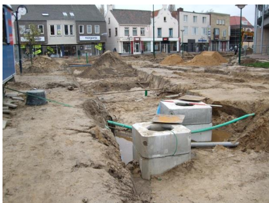
Afbeelding 5: Aanleg infiltratierool bij het gemeentehuis
