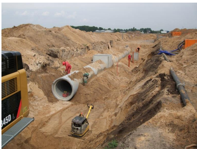
Afbeelding 6: Aanleg riolering Sterckwijk
