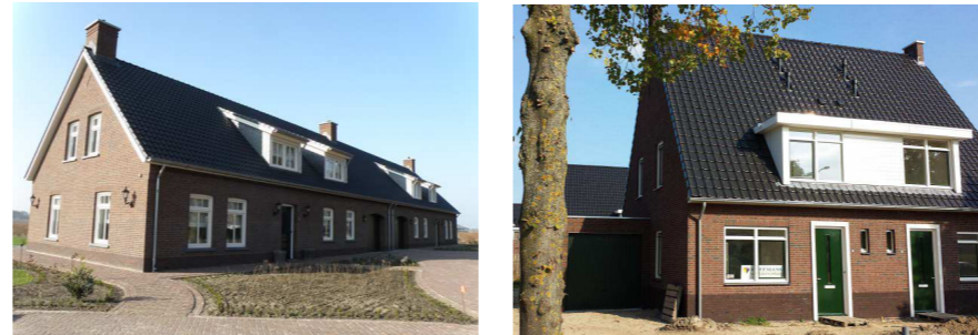
2 onder 1 kap woningen
