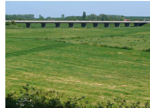
Het dijktafud loopt ongehinderd onder de brug door. Geen hiërarchie in de kolommen
