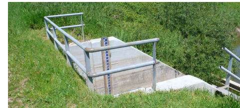
Betonnen wanden volgen talud
