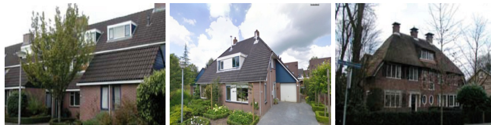
Diverse voorbeelden van dakkapellen en aangekapte dakkapel op een rieten dak
