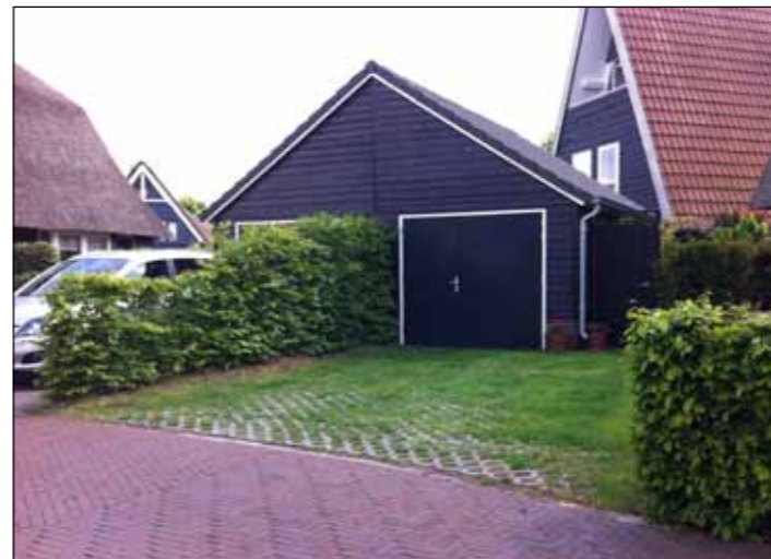
Informele inrichting met gebakken klinkers en open tegels (5.2)
