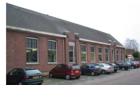
het voormalige schoolgebouw dient gehandhaafd te blijven
