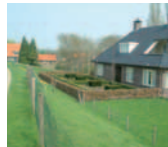
Nieuwbouw buiten profiel van vrije ruimte
