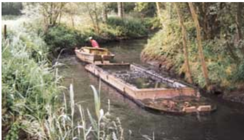
Vervuilde bagger wordt afgevoerd.
