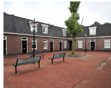
Nieuwe bebouwing sluit in massa en uitwerking aan op bebouwing het dorp
