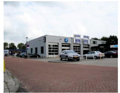
Bedrijfshallen van verschillende formaten in een dichte structuur
