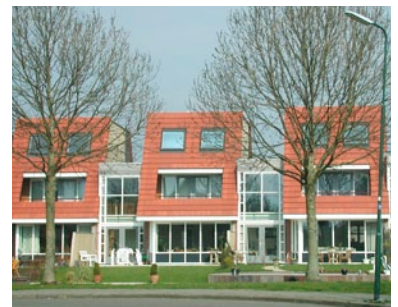
Woningen aan de Lisdodde wijken af in massaopbouw, materiaal en kleur
