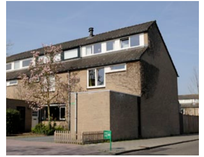
Enkelzijdige nokverhogingen aan de achterzijde van woningen
