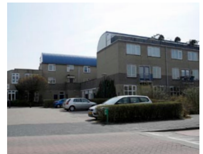
School met daarboven woningen wijkt af in massa opbouw en vorm
