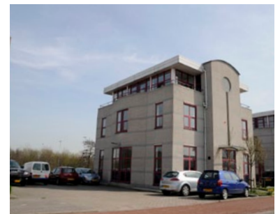
Doorzichten zorgen voor de relatie met het achterliggende water
