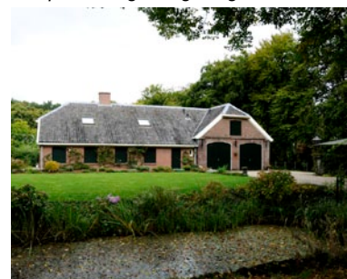
Bijgebouw Slot Zuylen is zorgvuldig en relatief eenvoudig gedetailleerd
