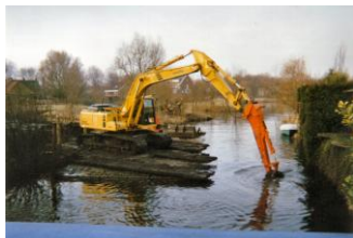
baggeren van waterbodems
