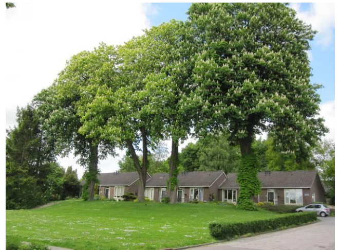
sterk – open ruimte in het dorp met monumentale boomstructuren
