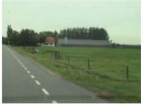
Wit gepleisterd hoofdgebouw (Zevenhuizerstraat)
