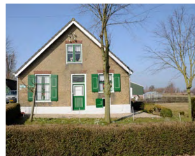
Gebouwen hebben een onderbouw van één tot anderhalve laag met kap
