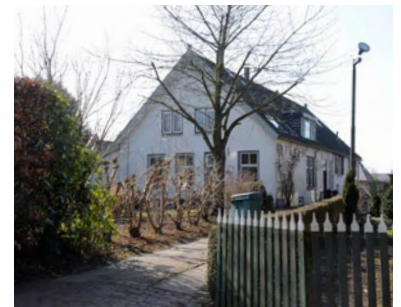
Gevels zijn van baksteen of stucwerk, eventueel aangevuld met houten delen
