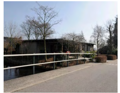
Individuele en afwisselende bouw langs groene straten
