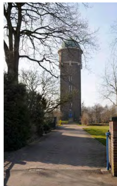
Bijzonder element is de watertoren aan de Dijklaan in Bergstoep
