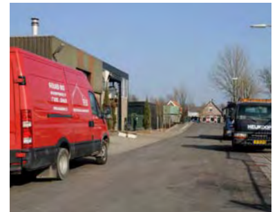
Kleinschalige bedrijfshallen in een open structuur
