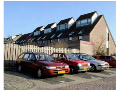
Dakopbouw gelijkvormig aan eerder geplaatste opbouwen in hetzelfde dakvlak
