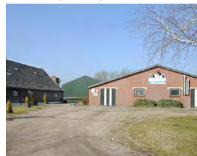
De hallen hebben een onderbouw van één laag met een zadeldak
