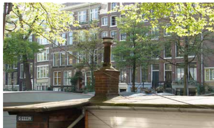
Schoorsteen op dak
