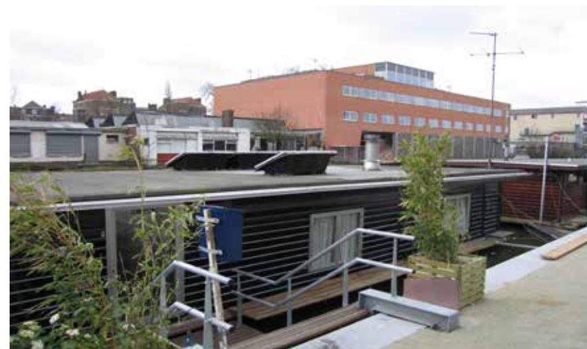
Plat dak met overstek
