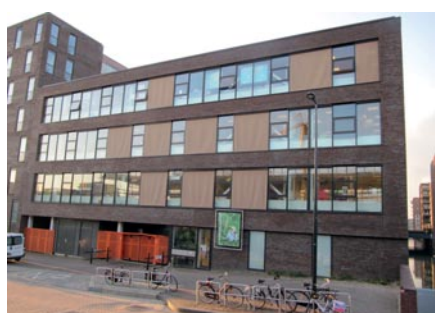
Kantoorpand Johan Huijsenstraat
