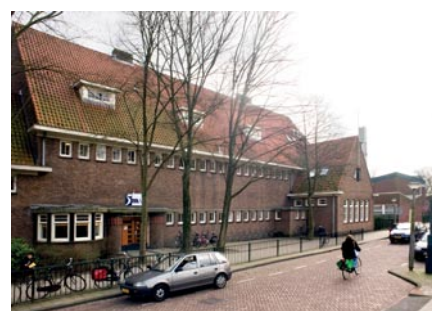
5e Montessorischool Betondorp
