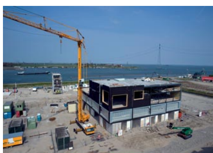
IKC Zeeburgereiland in aanbouw
