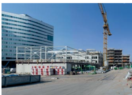
Montessorischool de Amstel in aanbouw
