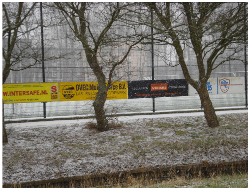
Buitenreclame op de Haarlemmerweg. De hekken aan de buitenzijde van het terrein worden hier gebruikt als reclamedrager. Dit is niet conform het beleid.
