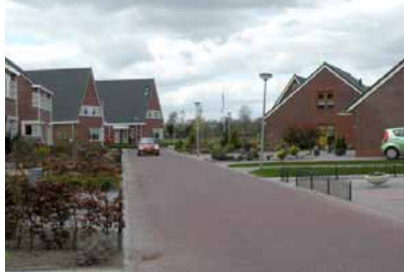
Bestaande klinkerverharding Rabatstrook verharding (met molgoot, zonder band) Bestratingspatroon en gootdetail bestaande woonstraat
