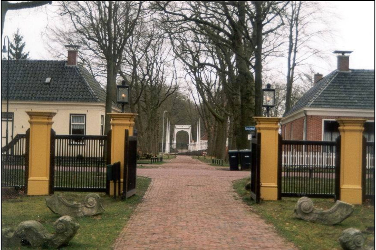
Afbeelding 25: Doorkijkje ter hoogte van Hoofdweg 17 te Slochteren.
