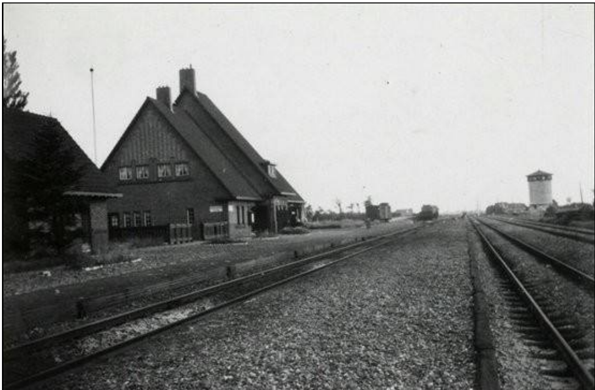
Afbeelding 21: Spooremlacement Slochteren met stationsgebouw en watertoren (bron: www.nntfm.nl ).
