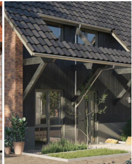
doorlopend dak door overstek
