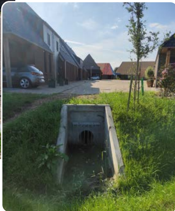
Afbeelding 38: Uitstroomconstructie hemelwater bij cluster
