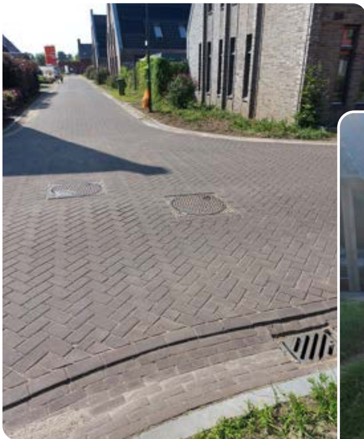
Afbeelding 37: Inspectieputten in de weg
