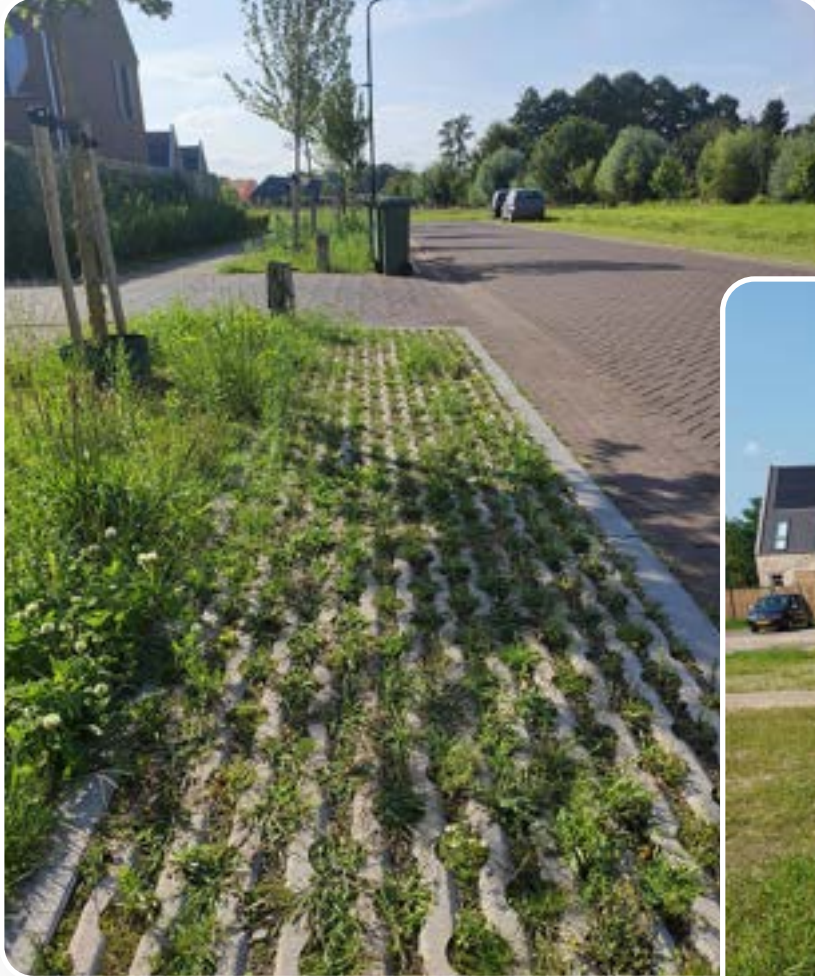
Afbeelding 17: Containeropstelplaats in grasverharding
