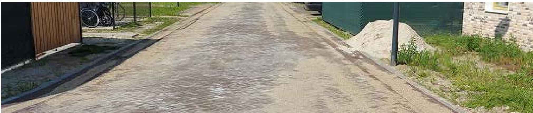
Afbeelding 6: Rijbaan met afwateringsvoorzieningen in woonstraat
