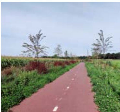
Afbeelding 186. Bestaande hoofdfietsverbinding die door het plangebied loopt.
