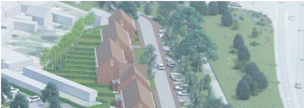
Figuur 14: Vogelperspectief van plangebied – fietspad – Oostelijke Randweg A50
